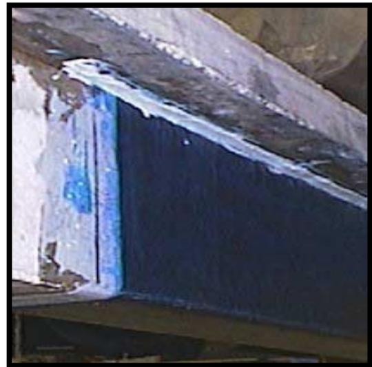
**(d) Filling the groove with epoxy paste**
